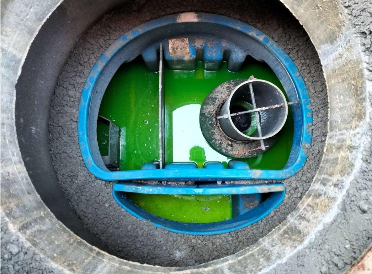
Petit séparateur conforme avec la plaque visible (filtre immergé non visible sur la photo), mais semble ne pas avoir été remis en eau lors du dernier entretien
