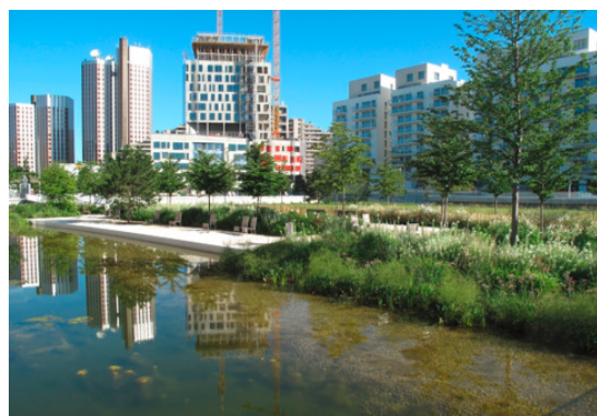
Le parc central récupère les eaux de pluie du quartier ZAC du Trapèze – Boulogne-Billancourt (92)
