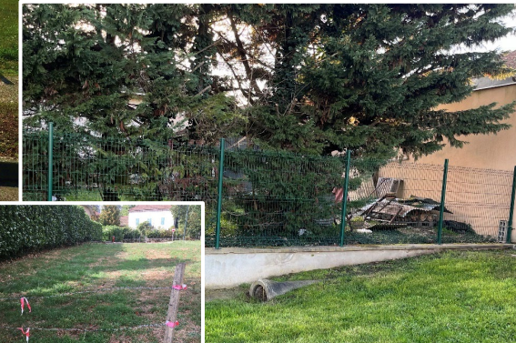
rejet canalisé d'eaux pluviales sur le sol en amont du projet
