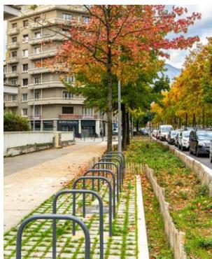
Deux projets d'aménagement qui ont intégré la gestion de l'eau de pluie par infiltration en contexte urbain : drains pour infiltrer les eaux de toitures, bordures ajourées et effacement de bordures, végétalisation et désimperméabilisation.
